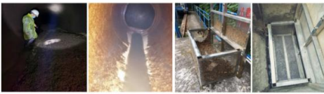
原水管内壁清洗前后对比
